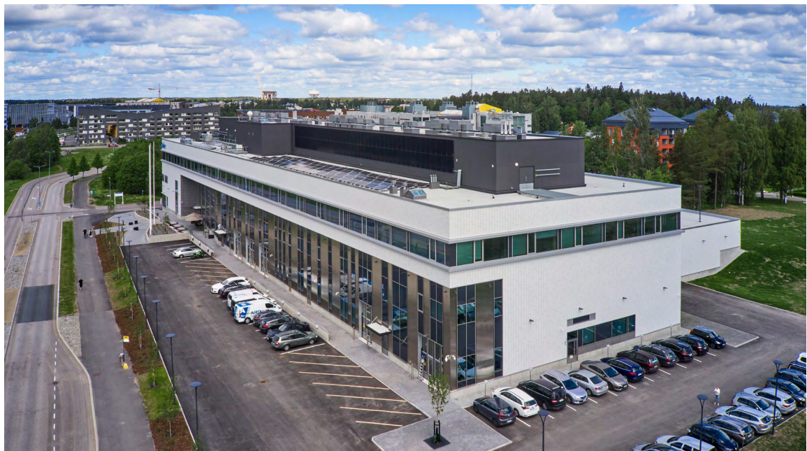
KUVA 3. STUKin toimitilarakennus, jonka katolla näkyvät aurinkopaneelit.
