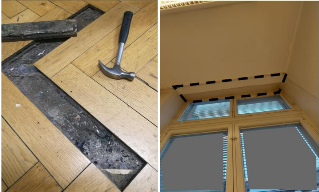
Kuva 30. Sauvaparketti on kiinnitetty alustaan bitumiliimalla. Tutkitun tilan 4.2.1 ja ylemmän kerroksen välille on tehty myöhemmin uusi välipohja ja kerrosten välille, ulkoseinälinjalle on tehty levytyksiä (katkoviiva), joiden taakse on jätetty vanhoja ikkunoita.
