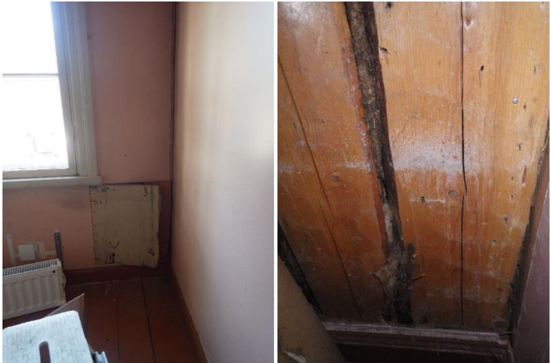
Kuva 36. Tilan 5.1 ulkoseinään tehty rakenneavaus, pystyhirsien välit on tiivistetty riveellä.
