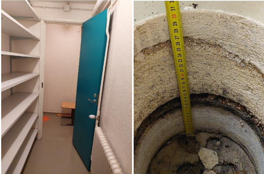
Kuva 12. Kuva tilan 1.2 puolelta tilaan 1.1. Timanttioraukset ulotettiin alapohjarakenteen läpi.
