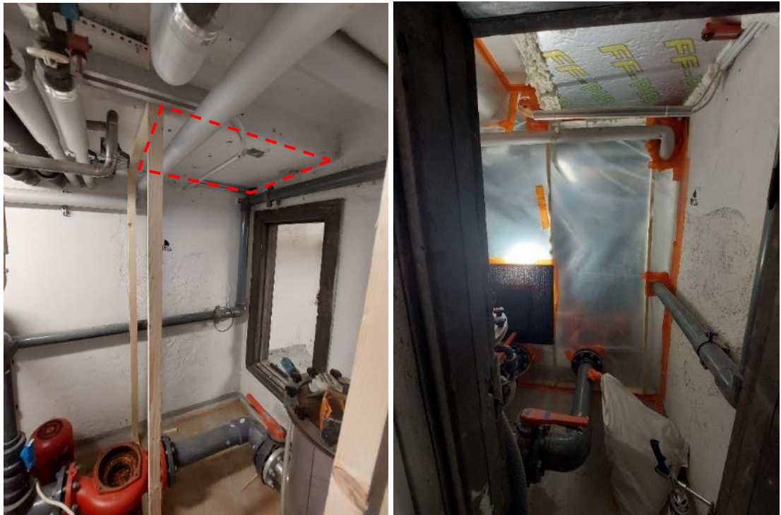
Kuva 27. Vasemmalla: Korkkilevy irrotettiin rakenneaineisen, rapatun IV-kanavan pinnalta (katkoviiva). Oikealla: Näytteenottoalue osastoituna ja paikattu alue IV-kanavassa.
