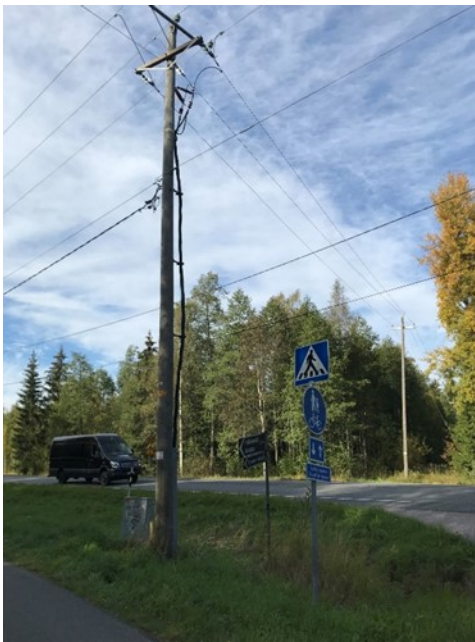
Kuva 16. Pylvästä maahan menevä 20 kV:n maakaapeli.
