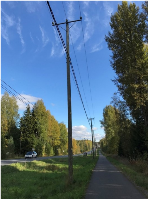
Kuva 7. Taso-orteen asennettu päällystämättömän 20 kV:n ilmajohto.
