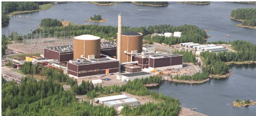
Kuva: Fortum Power and Heat Oy
