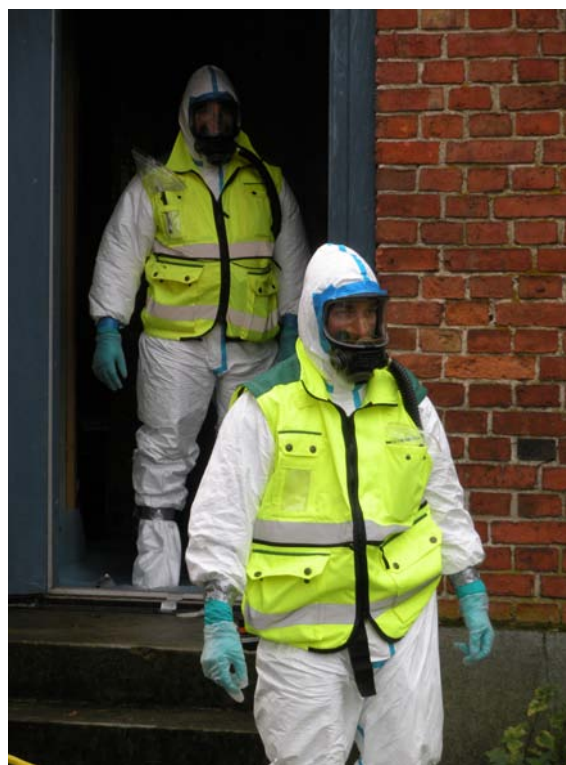
STUKin asiantuntijat Antti Kallio (edessä) ja Petri Smolander ovat varustautuneet työskentelemään radioaktiivisilla aineilla saastuneessa rakennuksessa.
