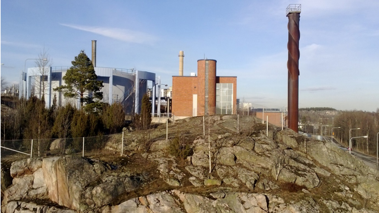
Kuva 11.1. Viikinmäen jätevedenpuhdistamo. Bild 11.1. Viksbacka avloppsreningsverk. Fig. 11.1. Viikinmäki wastewater treatment plant.
