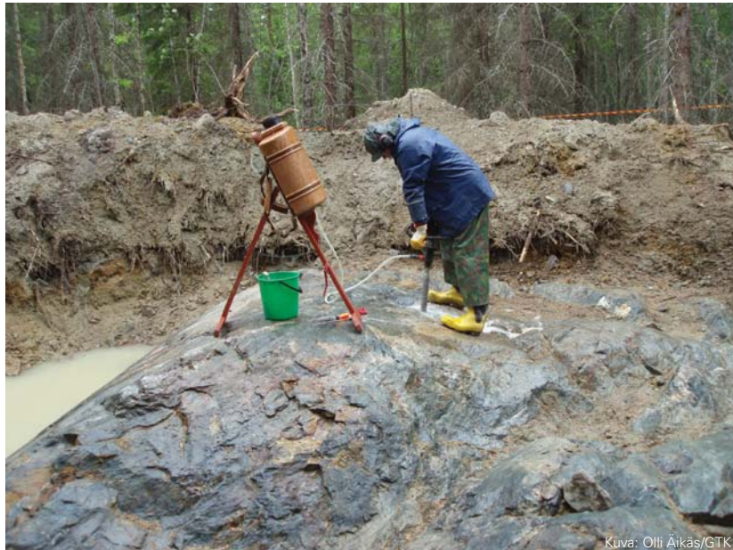
Näytteenottoa pienoiskairalla tutkimuskaivannon kalliosta.
