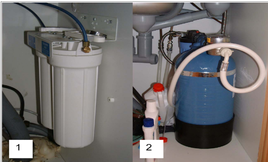
Kuva 8. Tässä Tekes hankkeessa testatut fluoridin poistolaitteet: 1 Alvitec Oy:n laite, 2 Callidus Oy:n laite
