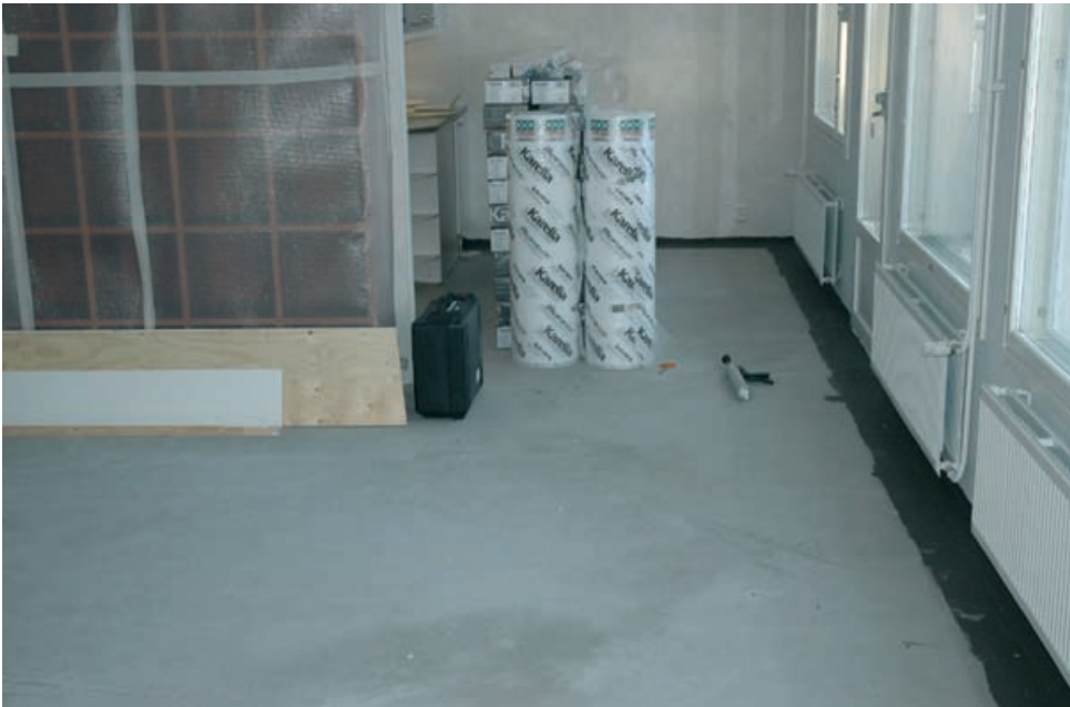
Kuva 6.5. Vedeneristysmassalla ja vahvikenauhalla suoritettu kaikkien lattiasaumojen tiivistämistyö pientalokohteessa. Erittäin karkeiden täyttöainesten johdosta radonimuri ei toiminut kohteessa halutulla tavalla.
