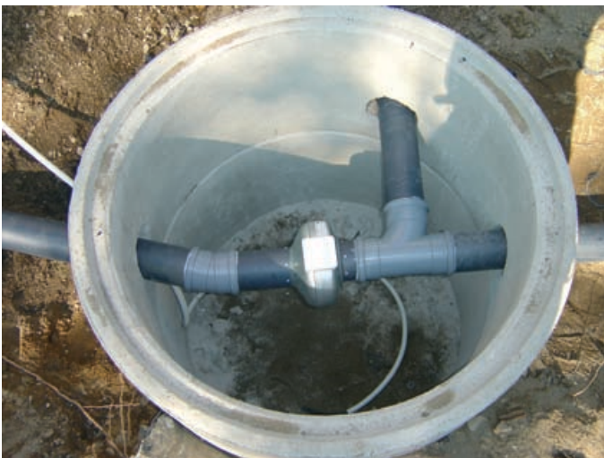
Kuva 5.14. Kahden erillisen imuhaaran liittymä ja kanavapuhallin kaivonrenkaassa.
