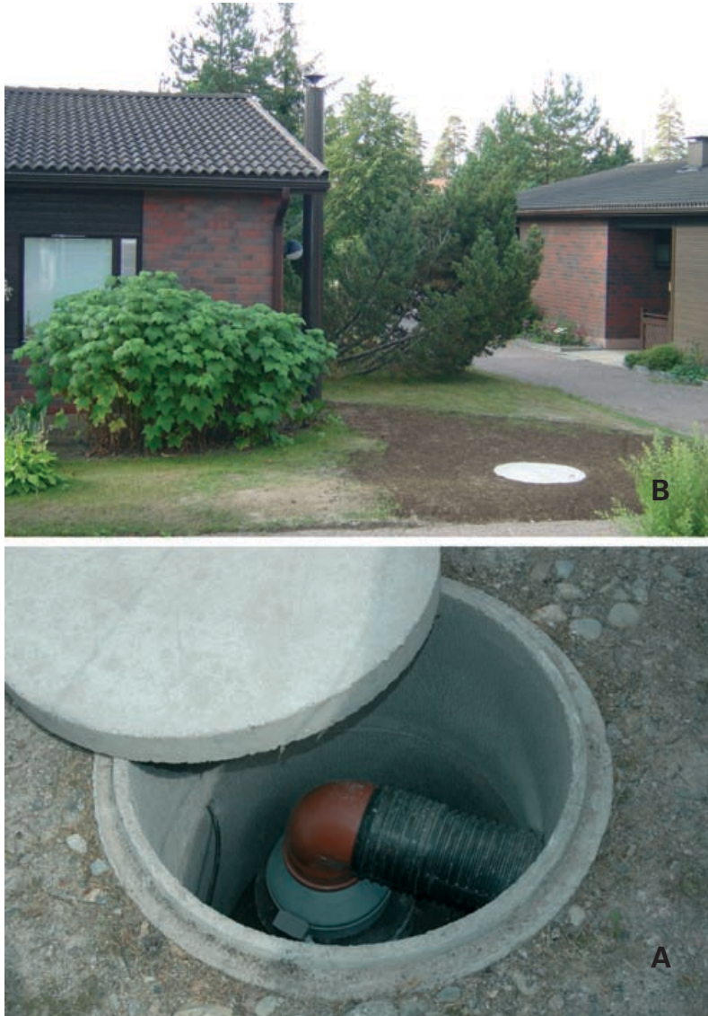
Kuva 5.7. Kaivonrenkaaseen sijoitettu poistopuhallin (A) sekä kaivon kansi ja korkea räystäään yläpuolelle asti ulottuva poistoputki (B).
