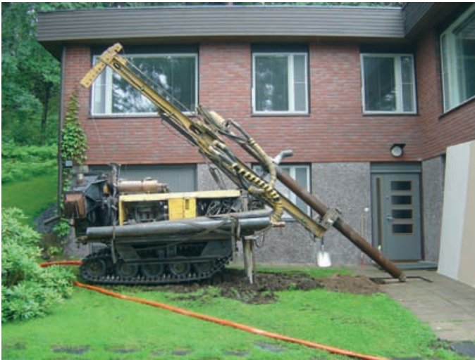
Kuva 5.13. Porakaivolaiteisto talon vierellä.
