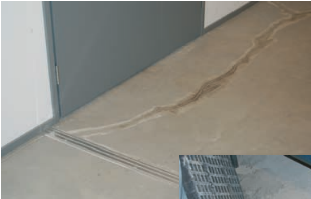
Kuva 11.1. Yliopistorakennuksen kellarikäytävän lattian halkeamien tiivistäminen suoritettiin epoksinnoitteella.
