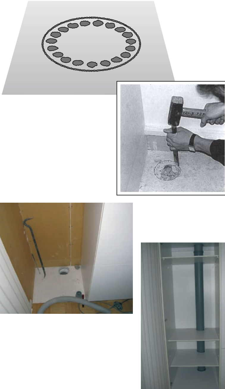
Kuva 4.9. Reikä läpiviennille voidaan toteuttaa poraamalla lattiaan reikiä ja piikkaamalla reikä auki. (Kaksi alinta kuvaa HT-Talo-Pojat Oy.)
