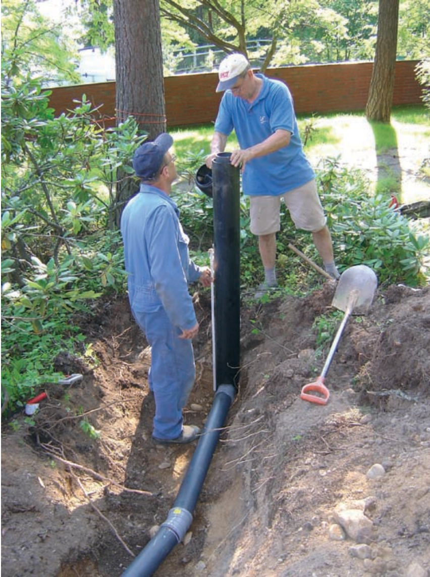
Kuva 5.15. Radonkaivon lämpöeristetty poistoputki pihamaalla. Myös vaakaosuudet lämpöeristettiin.
