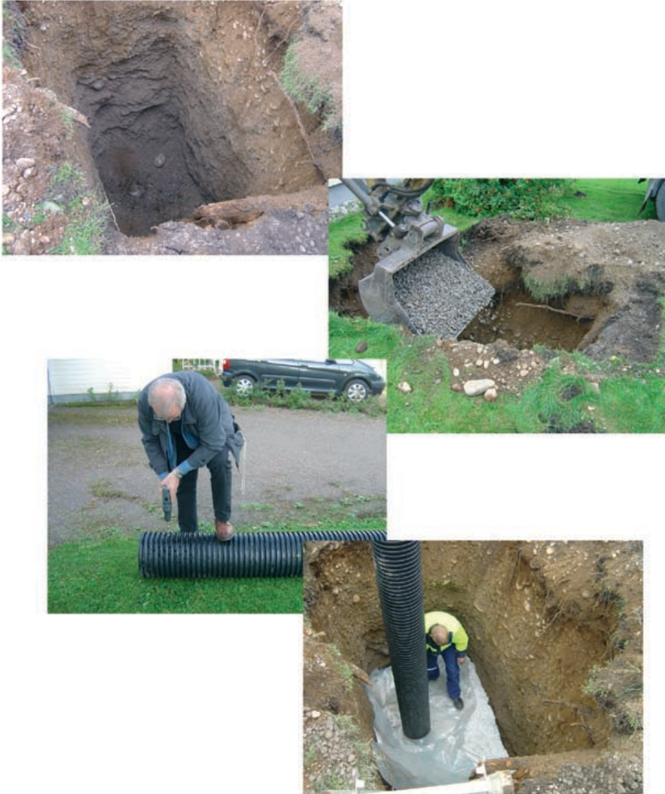
Kuva 5.9. Radonkaivon kuoppa, sepelitäyttöä, kaivoputken alaosan poraaminen sekä muovin asentaminen sepelitäytön ja suodatinkankaan päälle.
