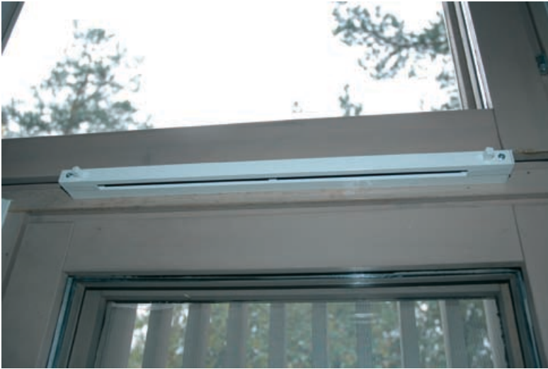
Kuva 10.2. Ikkunakarmin asennettu rakoventtiili.
