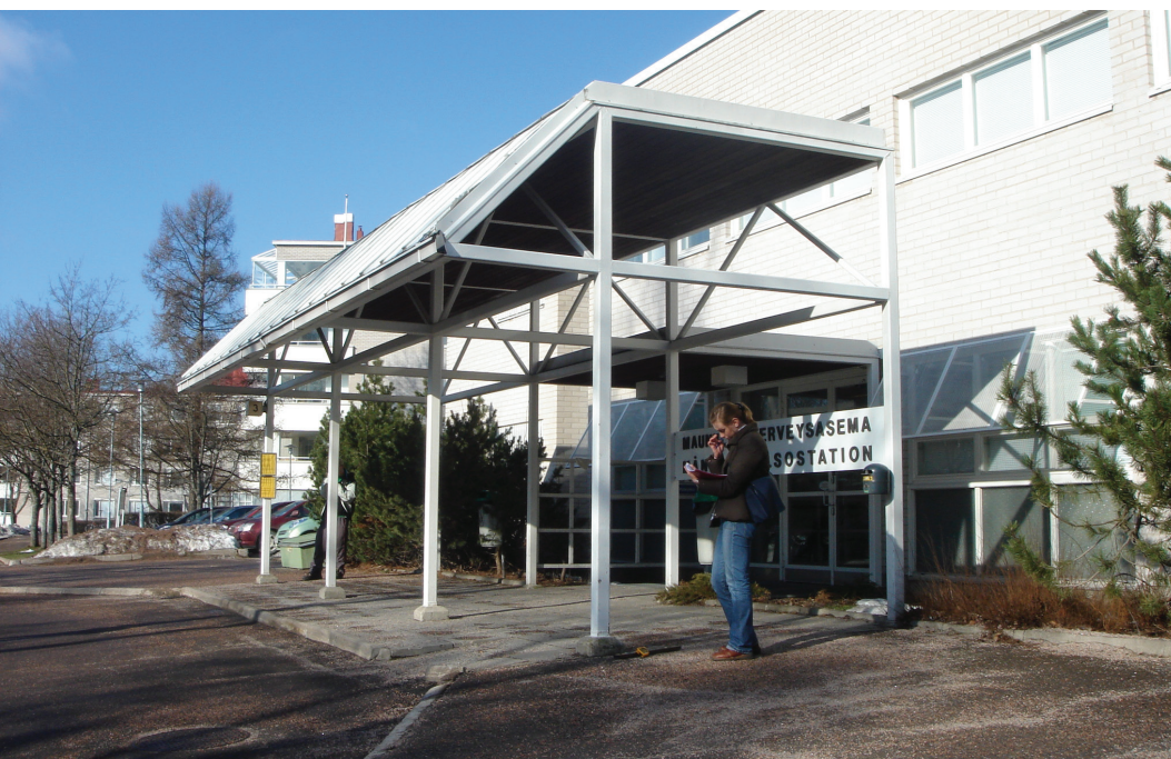
Kuva 3 Kulkureitti sisäänkäynnille. Kuva Niina Kilpelä.
