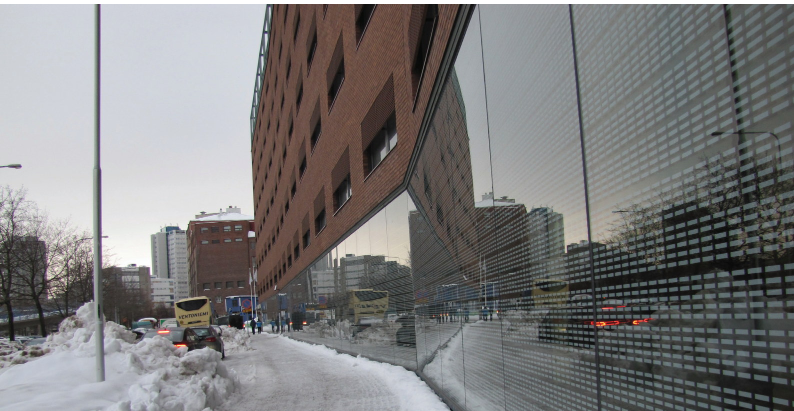
Kuva 19 Sisäänkäynnin havaittavuus. Katoksetonta sisäänkäyntiä on vaikea havaita julkisivusta. Kuva Niina Kilpelä
