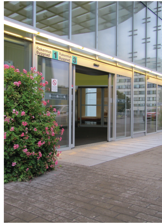
Kuva 2 Sisäänkäynti. Kuva Niina Kilpelä.
